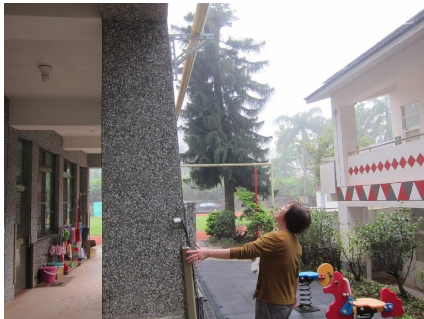
說明：防護組進行建物安全檢查
